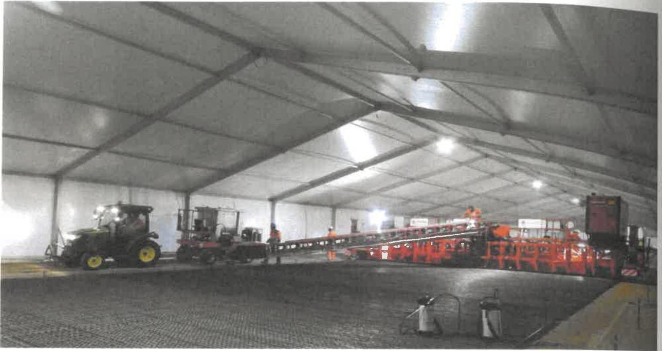
Abb. 6: Transport des Frischbetons mit einem Traktor zur Einbaustelle und der Einbau des Betons mit einem speziellen Fertiger
