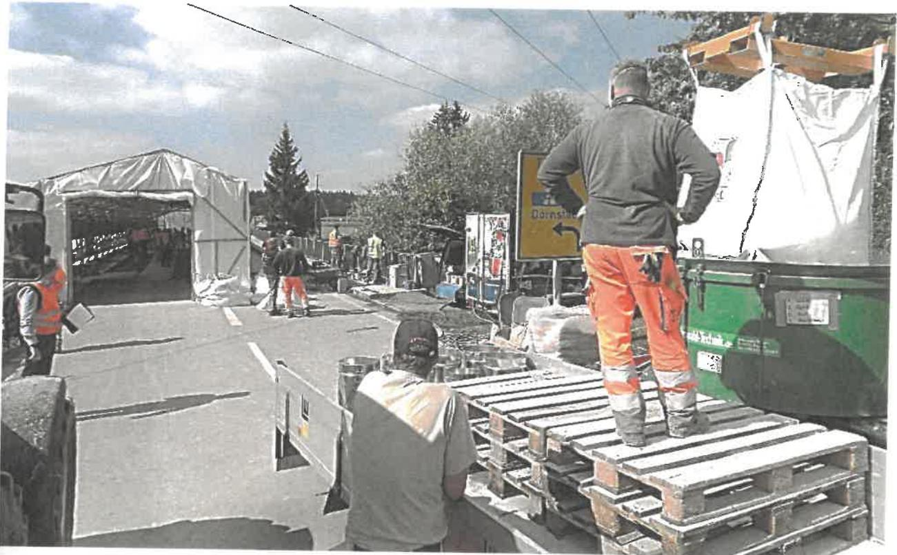
Abb. 2: Pilotprojekt in Beimerstetten, links Verlegen des Betons im Zelt, rechts Befüllen eines Zwangsmischers mit dem vorgefertigten Contec-Trockenbeton aus einem Big-Bag
