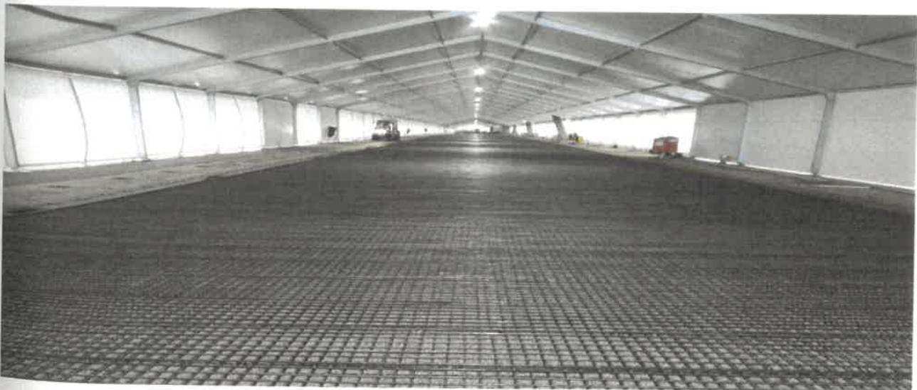
Abb. 5: Längs- und Querbewehrung des 1. Bauabschnittes im klimatisierten Zelt am 19.04.2019
