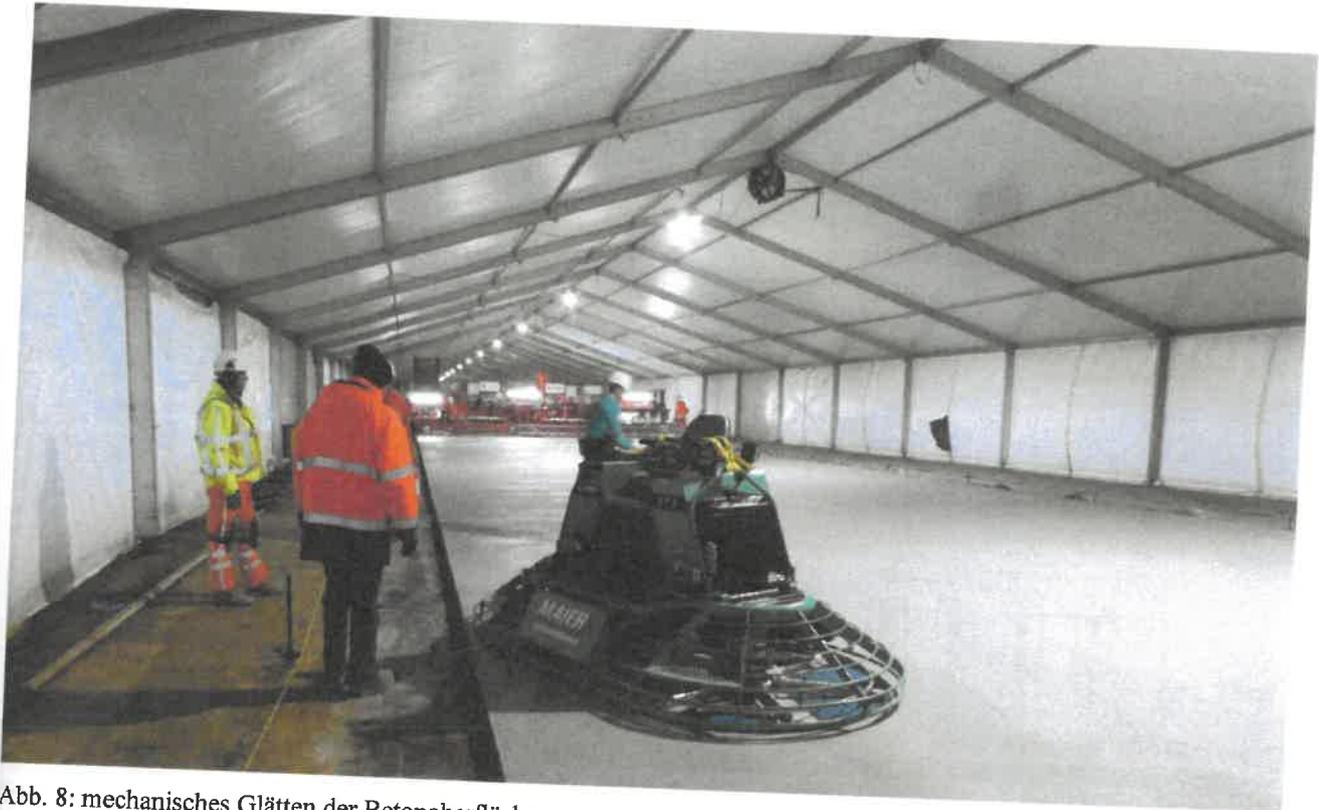
Abb. 8: mechanisches Glätten der Betonoberfläche
