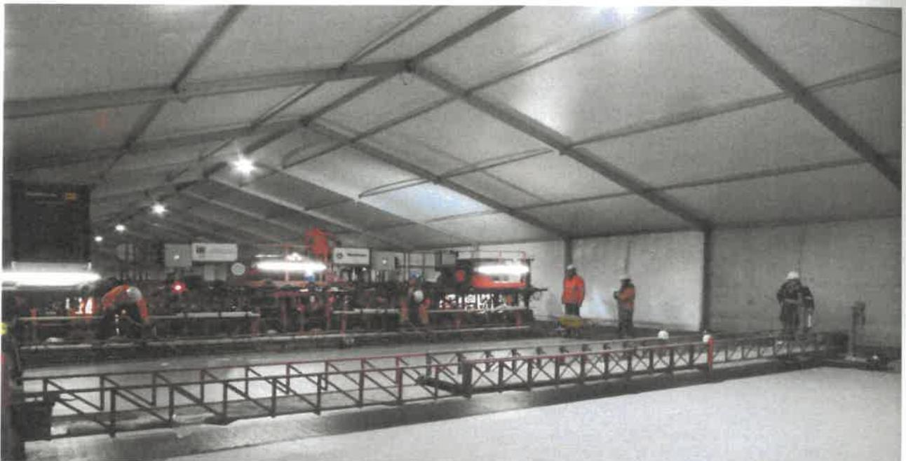
Abb. 7: Verlegen des Betons und Aufbringen des Verdunstungsschutzes nach dem Verdichten
